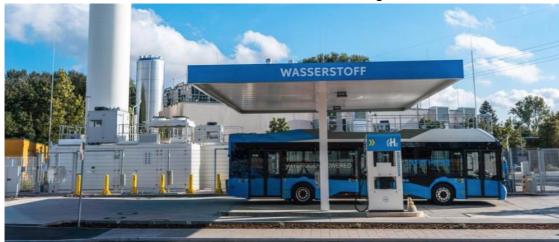
An der neuen Wasserstofftankstelle in Erlangen können Brennstoffzellen-Fahrzeuge ab sofort grünen Wasserstoff tanken. Bild: H2 MOBILITY Deutschland
